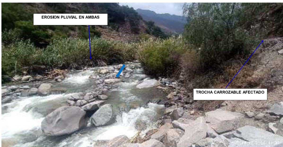
FIGURA N°02: CAUCE COLMATADO CON FLUJO DE DETRITOS Y ROCAS DE DIFERENTES TAMAÑOS EN EL RIO CÁRAC, SECTOR PUENTE ACOS, CAUSANDO EROSION EN AMBOS BORDOS DEL CAUCE Y TROCHA CARROZABLE AFECTADO.
