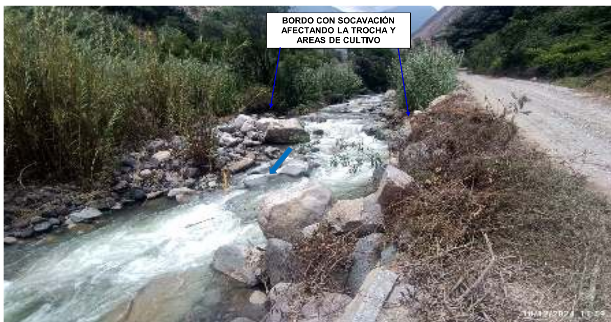
FIGURA N°03: TRAMO DEL RIO CÁRAC CON BORDOS EROSIONADOS, PONIENDO EN PELIGRO A LA TROCHA CARROZABLE MÁS IMPORTANTE DE ACCESO A LOS DISTRITOS DE LAMPIAN Y VEINTISIETE DE NOVIEMBRE
