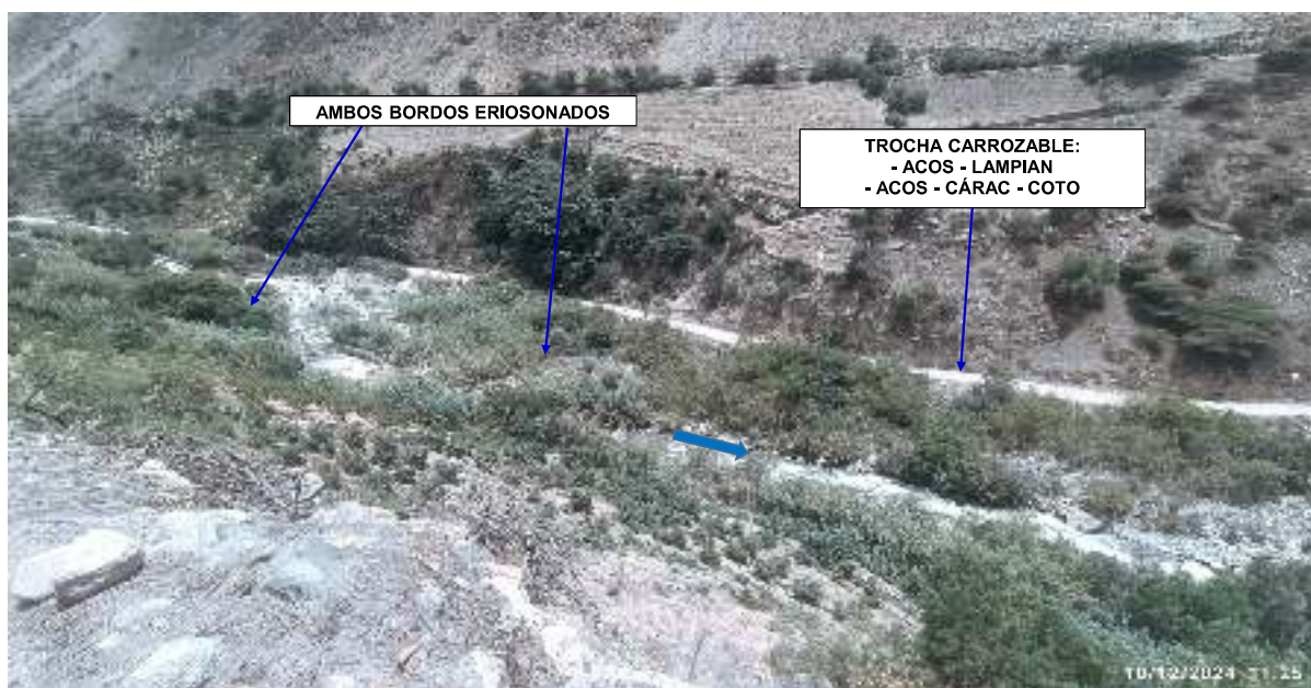
FIGURA N°01: TRAMO CRÍTICO POR FLUJO DE DETRITOS Y EROSION PLUVIAL EN EL RIO CÁRAC, EN EL SECTOR PUENTE CALLANTAMA, DISTRITO DE SAN MIGUEL DE ACOS, PROVINCIA DE HUARAL - LIMA.
